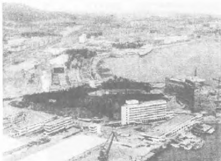
建设中的蛇口工业区
