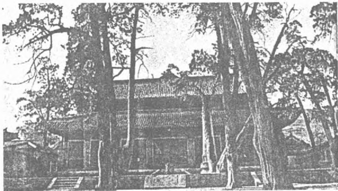
伏羲庙先天殿
